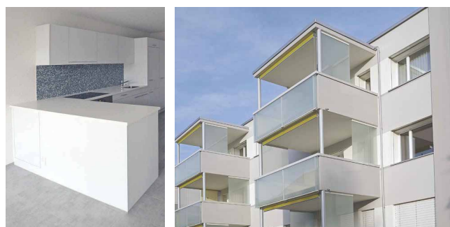
Rénovation complète Meisenweg à Thoune
